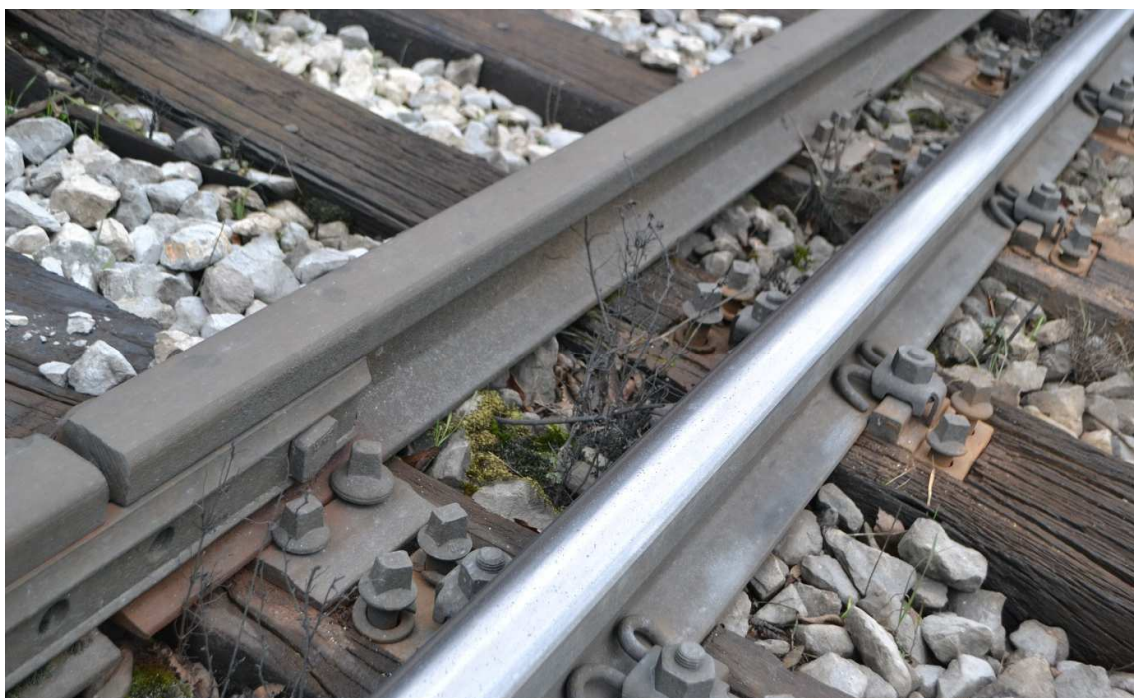
Slika 19 : Degradirani pragovi in neustrezno pritrjevanje
