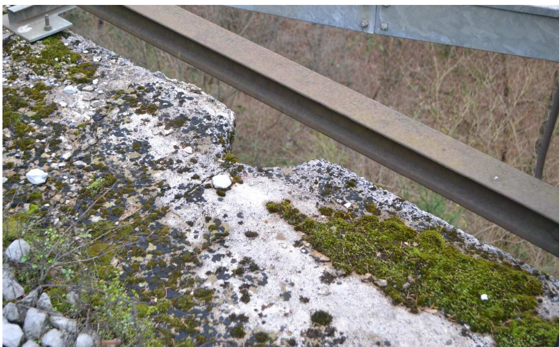
Slika 16 : Krušenje in razpadanje robnega venca in poraščenost z mahovi
