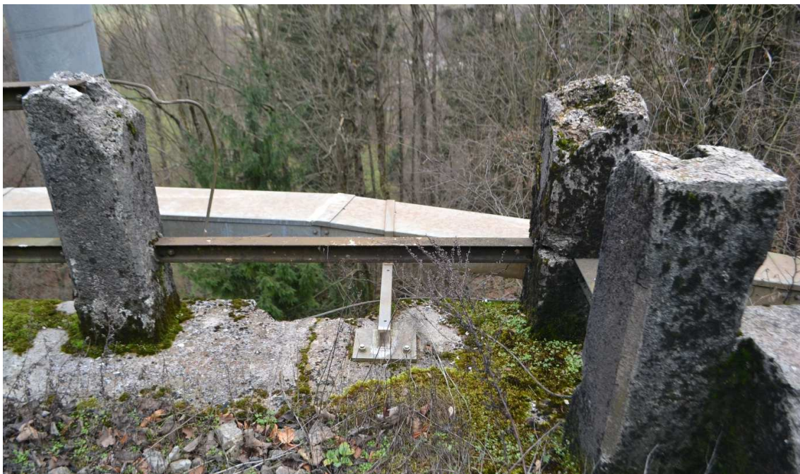
Slika 17 : Razpadanje betonskih stebrov ograje
