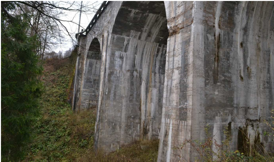
Slika 7 : Zamakanje in zasiganost
