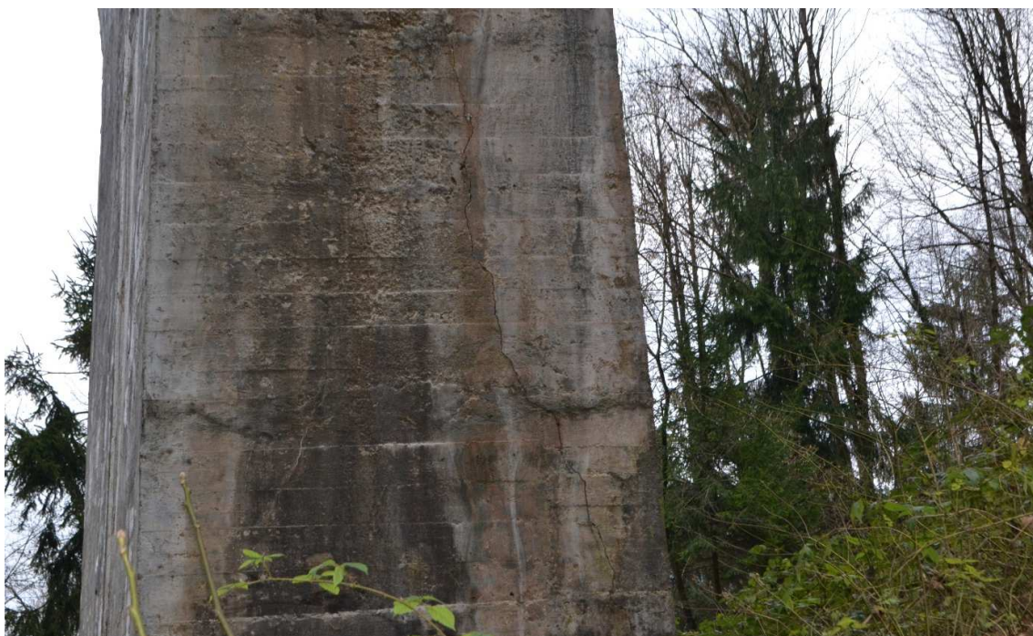
Slika 11 : Vertikalna razpoka na drugem podporniku
