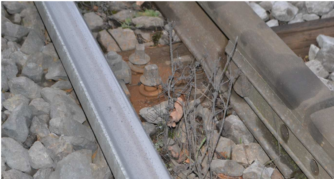
Slika 21 : Neustrezno pritjevanje
