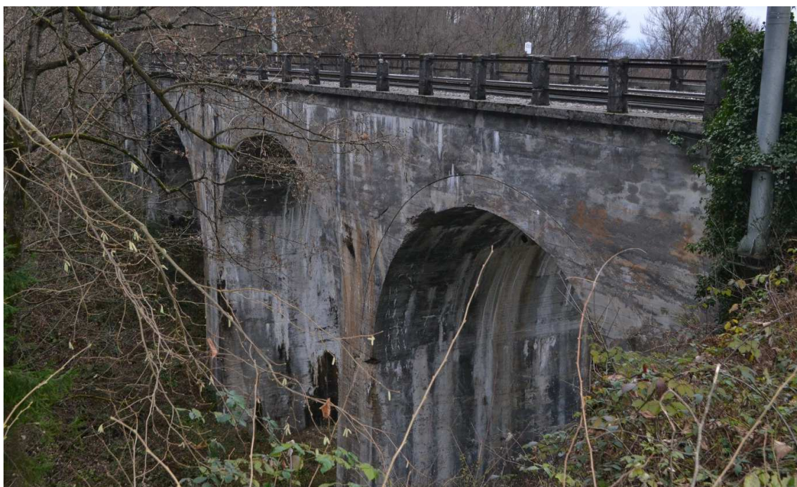
Slika 14 : Zamakanje, zasiganost in razpadanje betona
