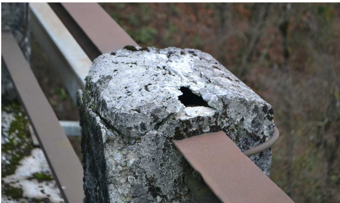
Slika 18 : Razpadanje stebrov in površinsko korodirana ograja
