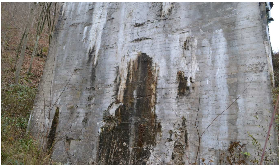
Slika 10 : Zamakanje, zasiganost in razpadanje in krušenje betona
