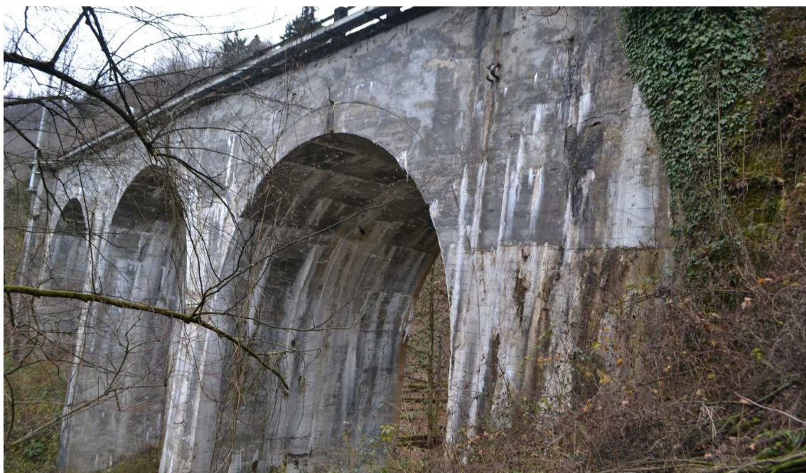
Slika 5 : Zamakanje, zasiganost in poraščenost krilnega kamnitega zidu
